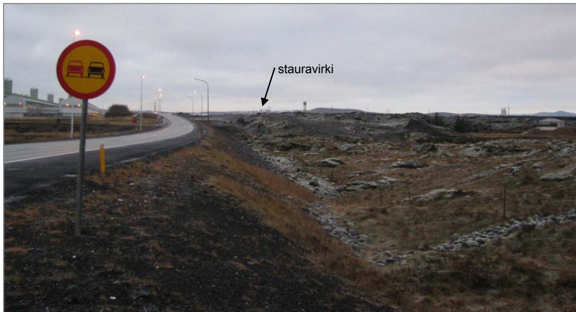
Mynd 9. Reykjanesbraut vestan við álverið. Vegurinn breikkar til suðurs um allt að 4,5 m vegna miðdeilis og fráreinar að undirgöngum. Rampi fráreinar að undirgöngum liggur milli stauravirkis og Reykjanesbrautar (Ljósmynd: Gunnar H. Jóhannesson, okt. 2010).
