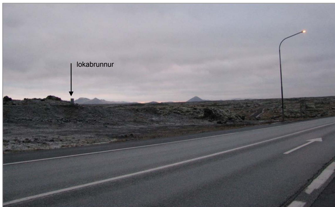
Mynd 13. Reykjanesbraut sunnan við álverið. Undirgöngin verða á milli lokabrunnsins sem sést á myndinni og Reykjanesbrautar. Brunnurinn er innan framkvæmdasvæðisins (Ljósmynd: Gunnar H. Jóhannesson, okt. 2010).
